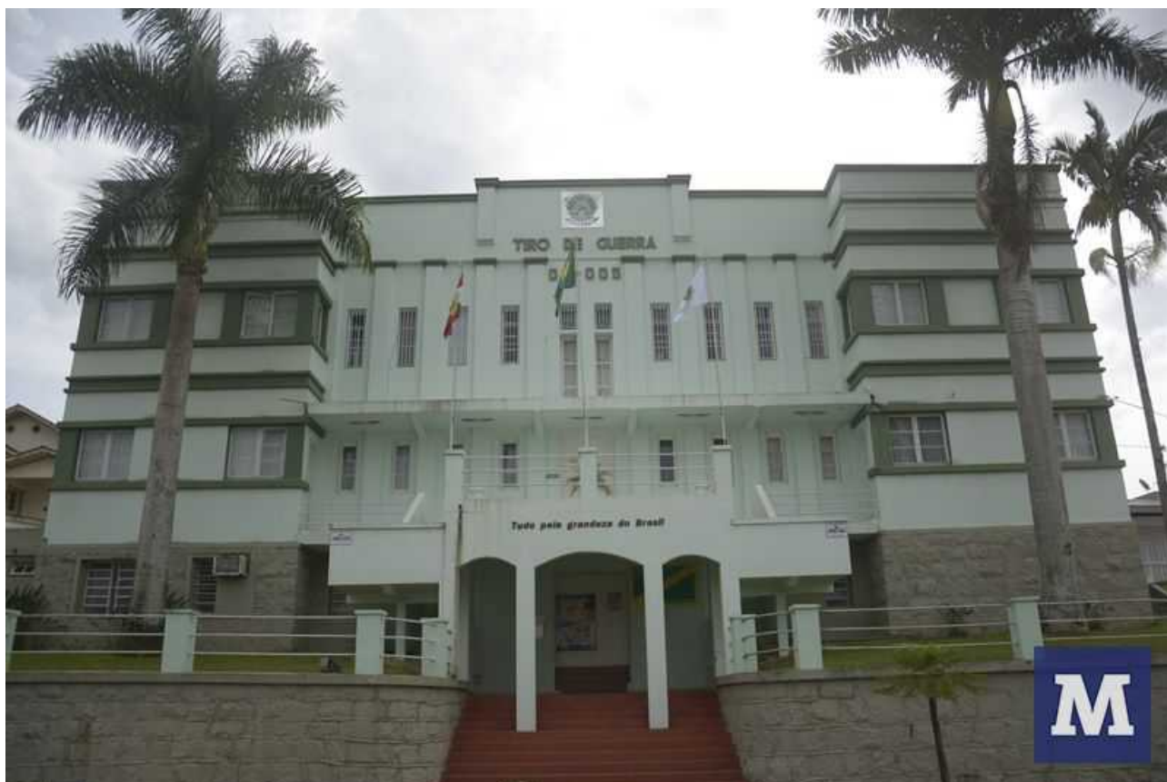
Figura 1: Edificação sede do Tiro de Guerra. Foto: Jornal O Município
