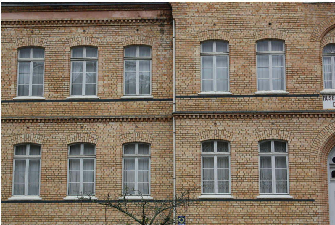
foto 34: aos fundos da área que corresponde a antiga ala da edificação, construída em 1907.
