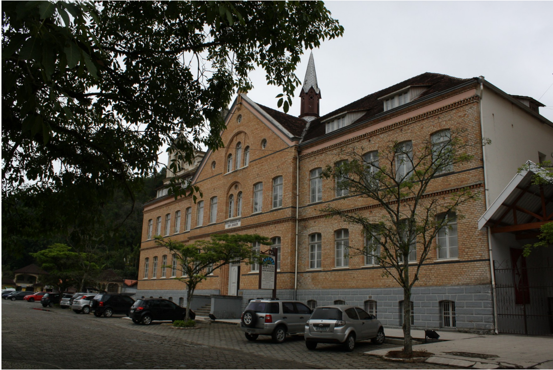
foto 33: o destaque do elemento central da edificação se faz por uma leve mudança de plano na fachada; a regularidade e a ordem são pressupostos desta arquitetura de base historicista.
