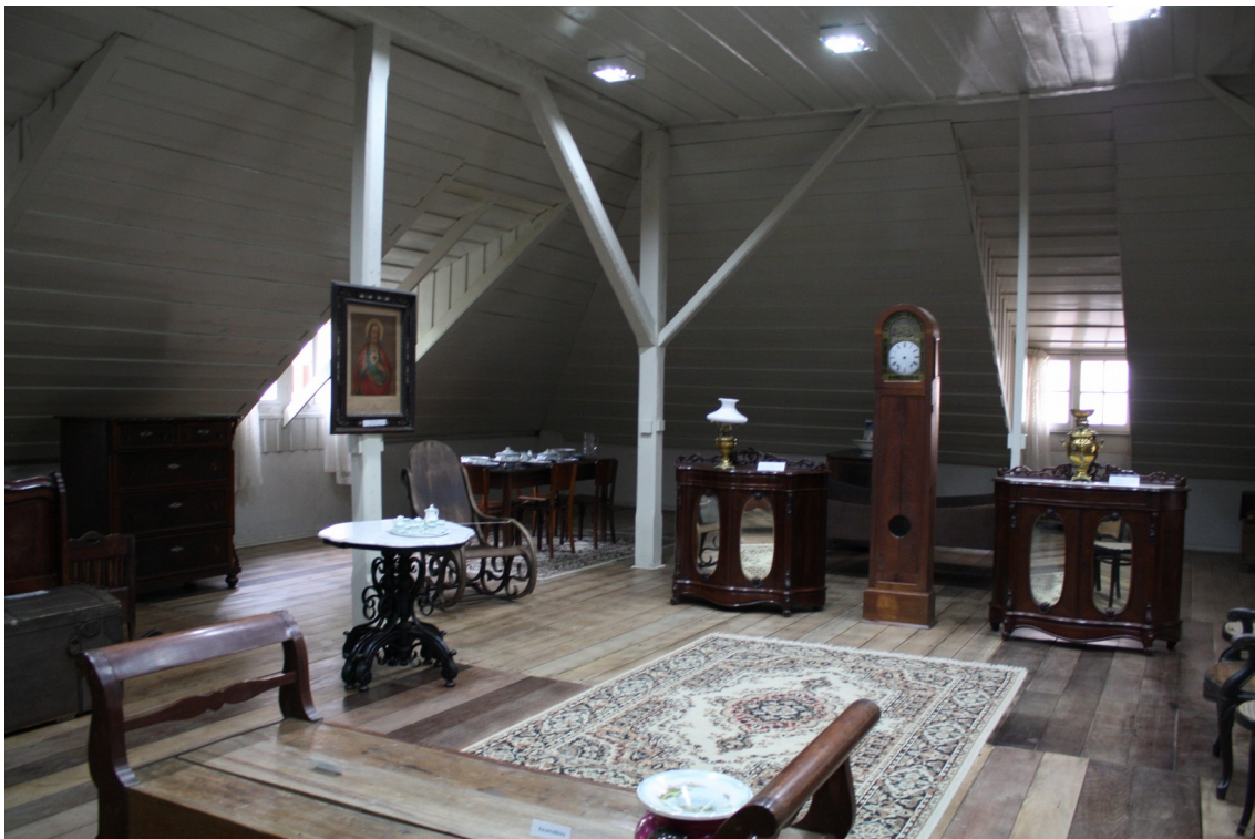
foto 38: vista do sótão da ampliação de 1930: já com um desenho de estrutura distinto da anterior.
