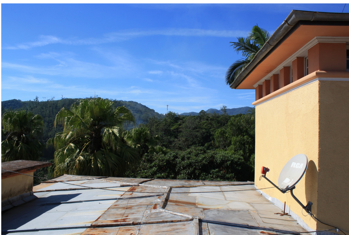
foto 46: vista da cobertura metálica original de proteção do telhado, com o volume de acesso a esta cobertura, cujas linhas lembram a arquitetura dos primórdios do arquiteto americano Frank Lloyd Wright.
