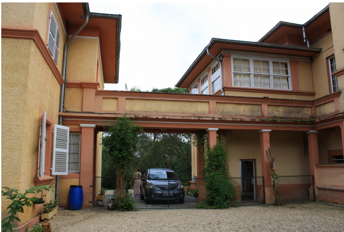
foto 45: vista entre as duas construções com a passarela sobre colunas que ligava os serviços aos cômodos no segundo pavimento.
