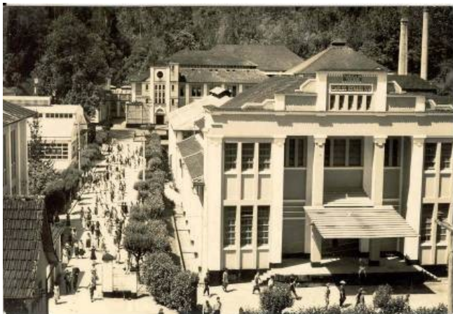
antiga fábrica: chaminé, e duas construções, em primeiro plano, vistas na imagem abaixo.
