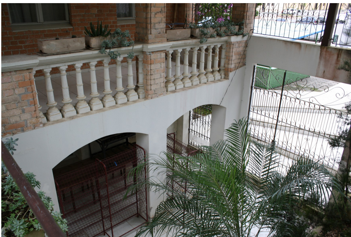
foto 36: vista do sub solo na área da ala mais antiga da edificação
