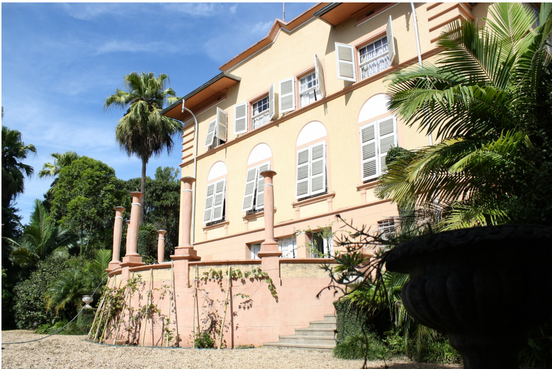
foto 42: vista da fachada da casa, com o pátio semi-circular em primeiro plano, aonde se localiza a cisterna de água que alimentava a casa.
