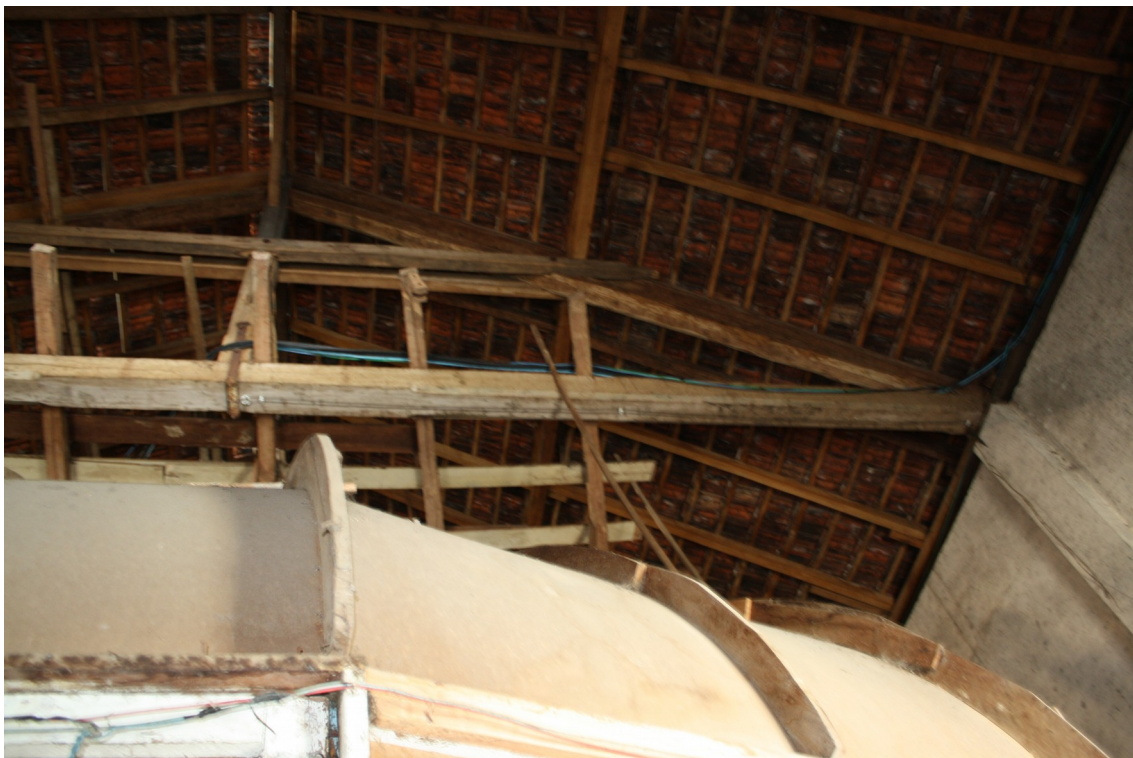
foto 27: vista da estrutura do palco e da estrutura de cobertura do telhado.
