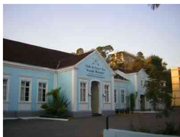
Clube de Caça e Tiro e o entorno, “rua das Carreiras”.
